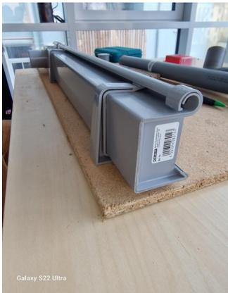
Mit der Eisensäge kürzen wir die untere Dachrinne auf 1,30 m. Mit dem Schleifpapier entfernen wir den entstanden Grat.
