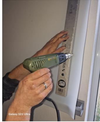
Ist das Material weich genug, dann biegen wir den Randstreifen ca. 45° nach oben. Diese Kante wird später dazu dienen, dass das Wasser nicht am Rand herunter läuft.
