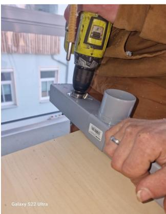
Mit der Bohrkronen bohren wir ein 40 mm großes Loch in der Mitte der markierten Stellen. An der gebohrten Stelle entsteht ein Grat, den wir mit Hilfe des Schleifpapier entfernen. Wir kleben den Ablauf an der Rinne fest, um undichte Bereiche zu vermeiden. Dies tun wir, indem wir Spezialkleber auf den Ablauf auftragen und diesen dann an der gewünschten Stelle einklicken lassen.
